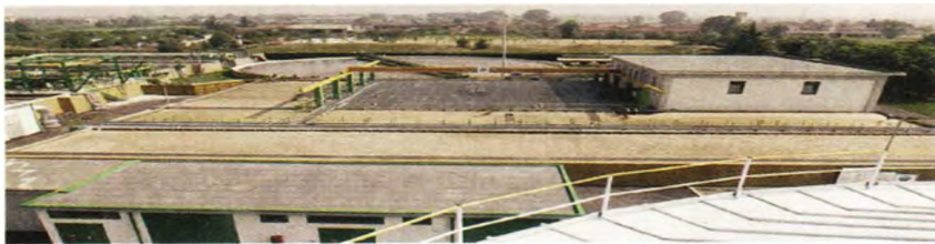
Станция очистки сточных вод в Brescia (Италия) производительностью 40 тыс. м 3 /сут
