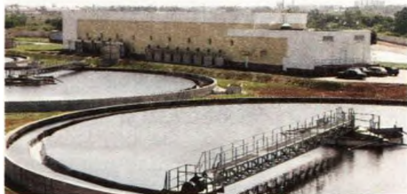
Комплекс ультрафиолетового обеззараживания (на втором плане) на Люберецких очистных сооружениях
