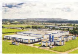
Юго-Западная водопроводная станция
