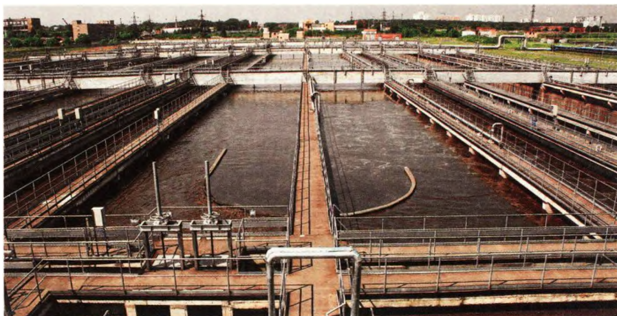
Блок удаления биогенных элементов на Люберецких очистных сооружениях
