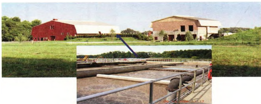
Очистные сооружения Sauley Creek (США) производительностью 20 тыс. м 3 /сут. Стрелкой показано месторасположение мембранного биореактора
