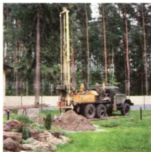
Бурение индивидуальной скважины
