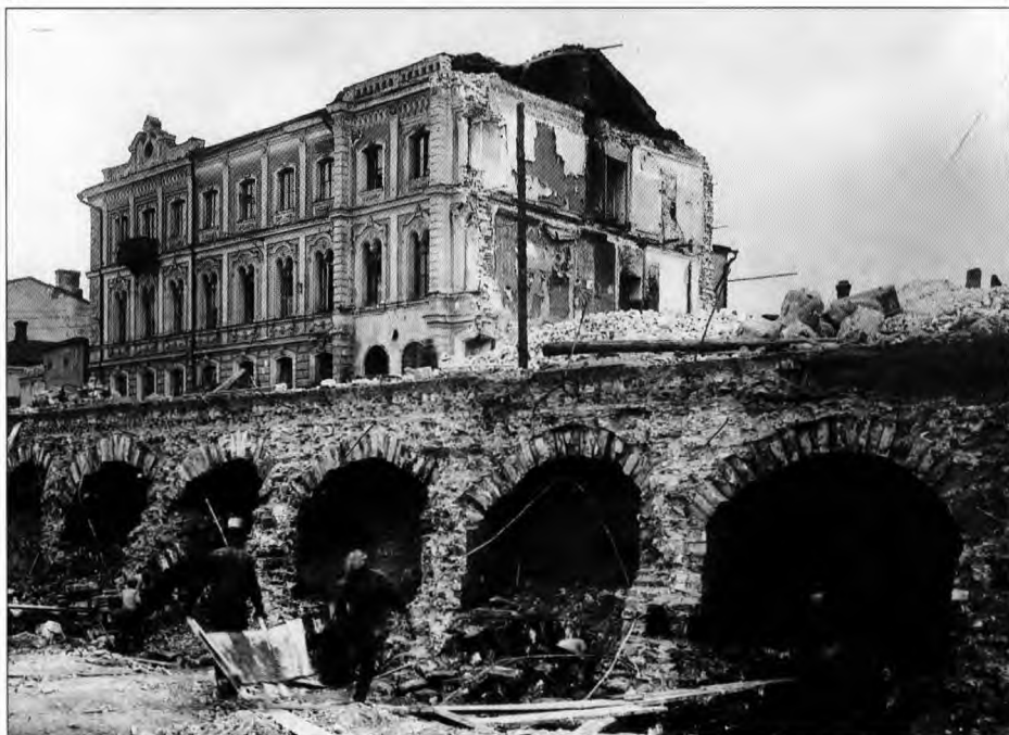
176 Старый Крымский мост. Инженер. В. Шлейер. 1873. Снимок 1934 г.
