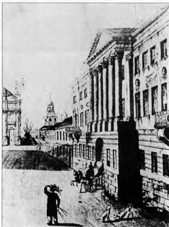
50 Дом Е.Козицкой, позже — З.Волконской, Тверская, 40 (Перестроен архитектором М.Казиковым). 1790-е гг.
