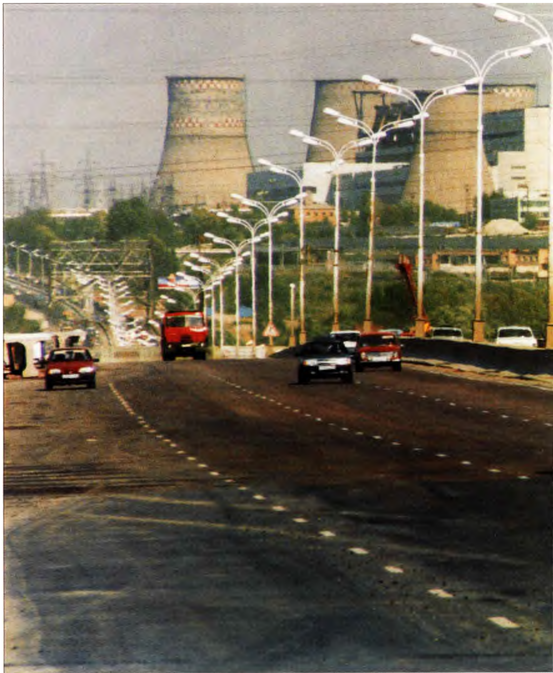
68 Московская кольцевая автомобильная дорога после реконструкции.
