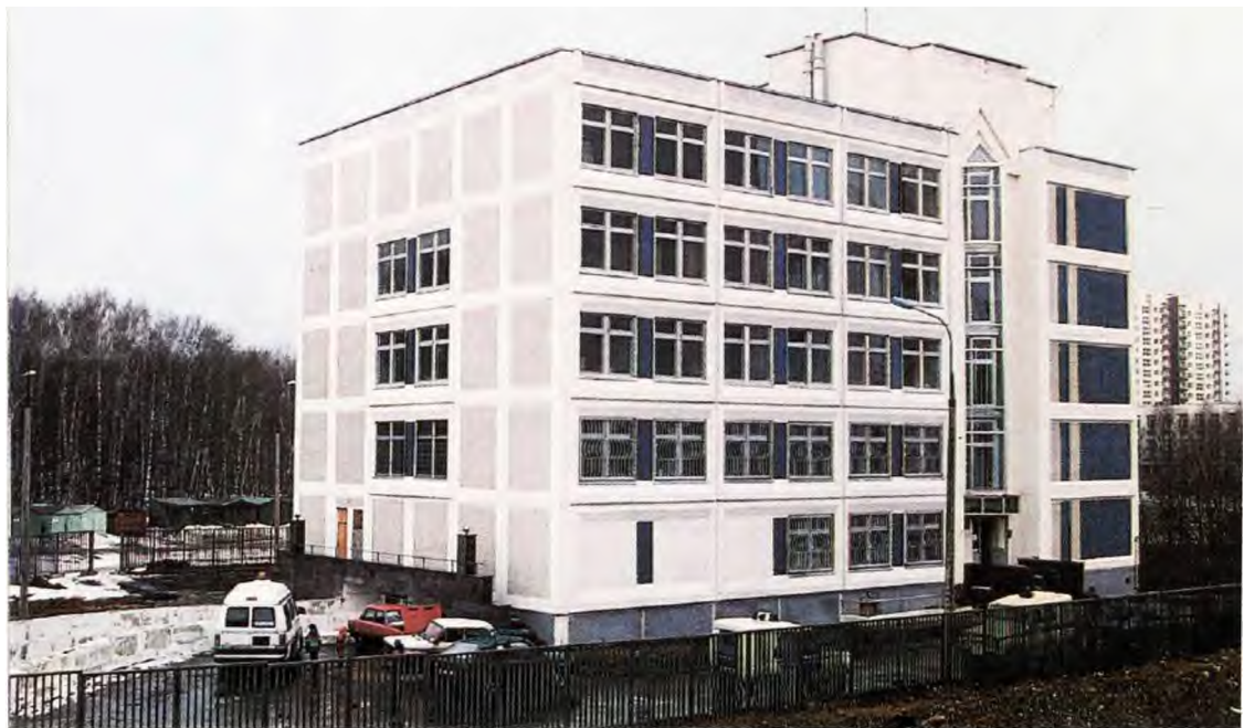
64 Автоматическая телефонная станция в Митино. 1995 г.
