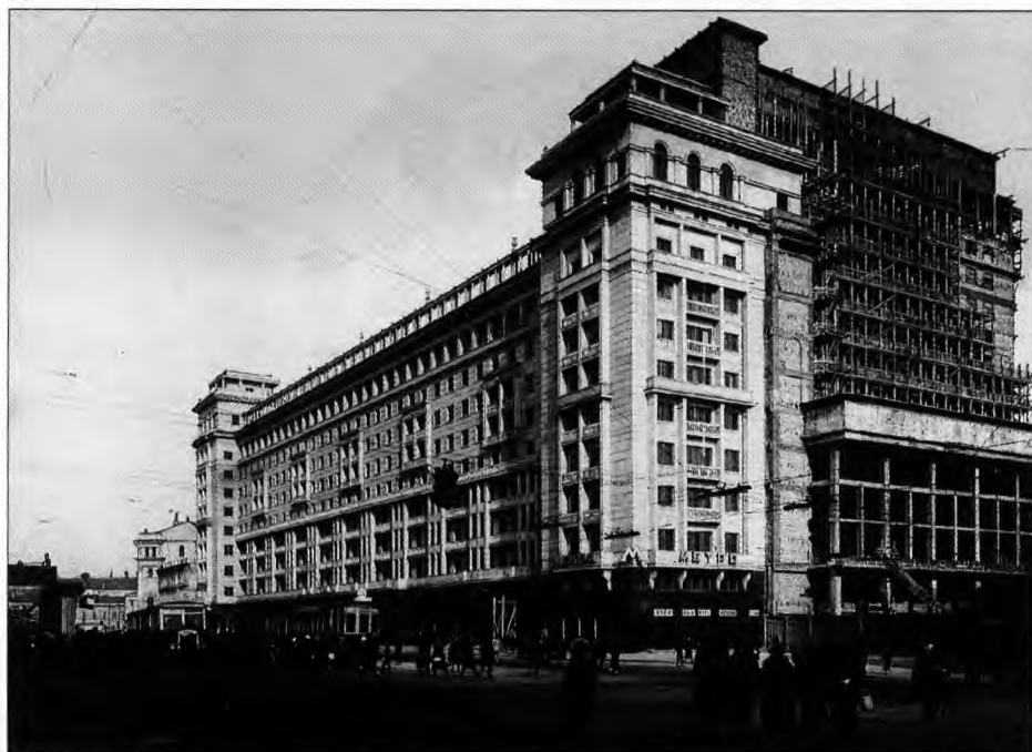
173 Здание на Мясницкой ул. Архитектор Ш. Ле Корбюзье, при участии Н. Колли. 1928–1938 гг.
