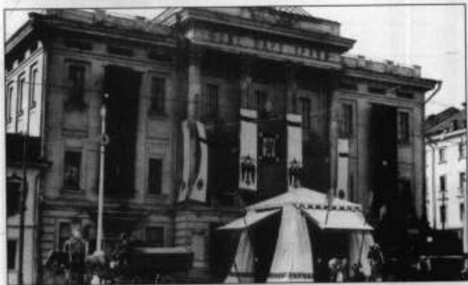
Сградата на Благородното събрание на ул. „Б. Димитровка“, украсена в чест на 300-годишнината на династията Романови, 1913 г.
