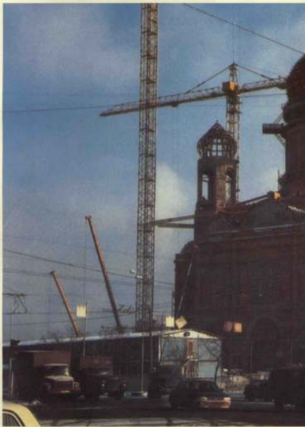
Hrist Spasitel Kilisesi yeniden inşa edilirken
