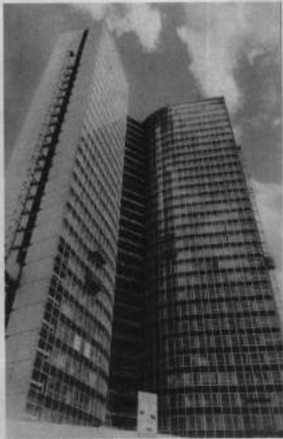
Kalinin bulvarındaki SEV binası, şimdiki Moskova belediyesi
