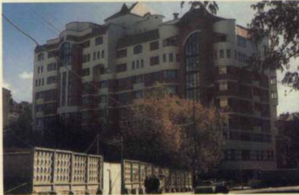
Konut İnşaatlarından bir örnek, 1995-1996
