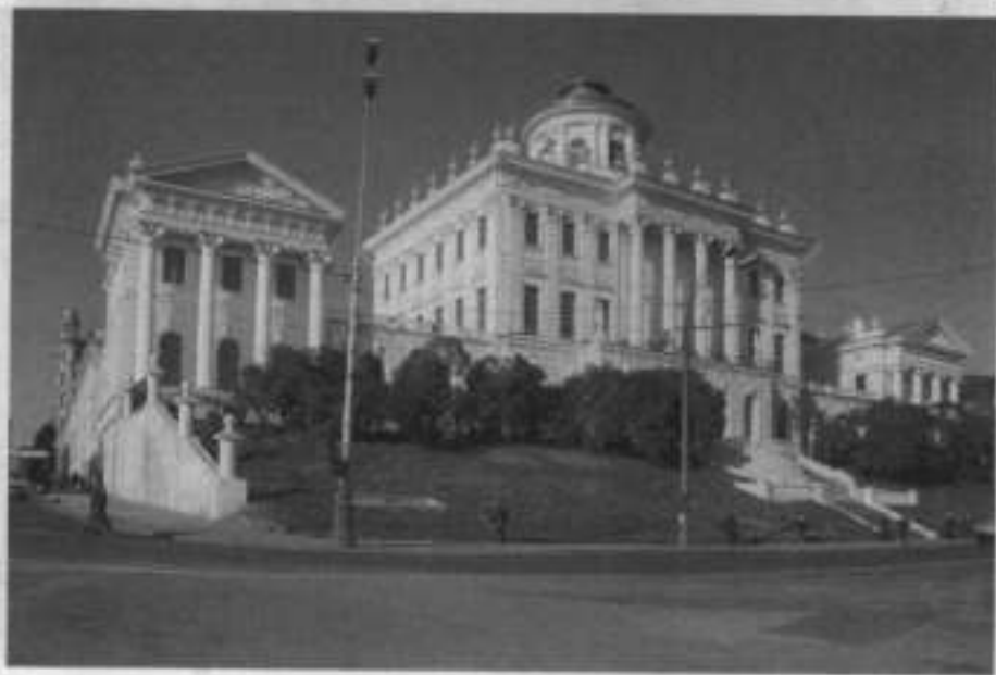
Sede della Biblioteca nazionale, ex palazzo Pubblico, in corso lavori di restauro
