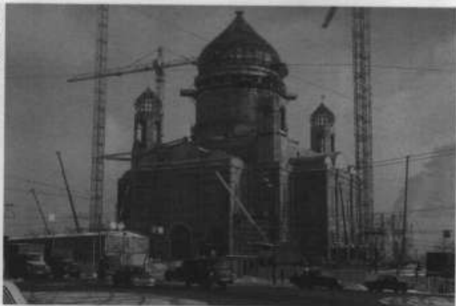
Il cantiere della Cattedrale del Cristo Salvatore nel 1906
