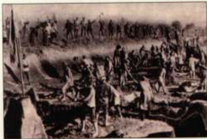
Manuelle Arbeit ist uneffektiv, doch die gebauten Kanäle transportieren Wasser bis heute
